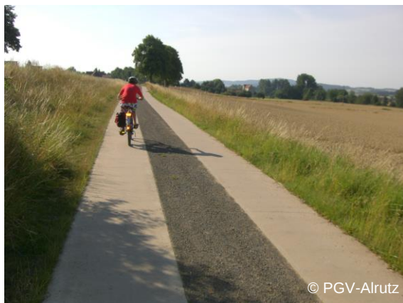
Spurweg mit Beton
